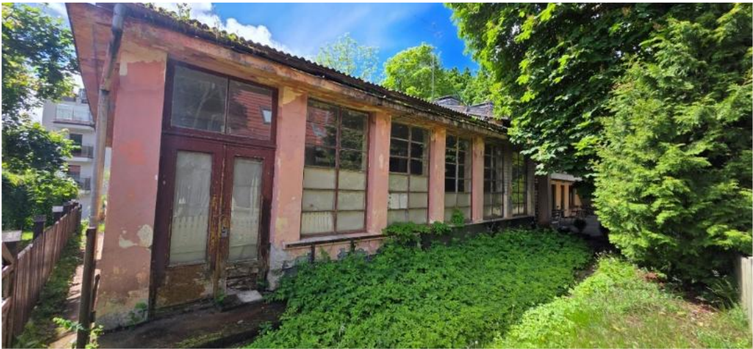
Šiaurės fasado fragmentas (pastato rytinė pusė)
