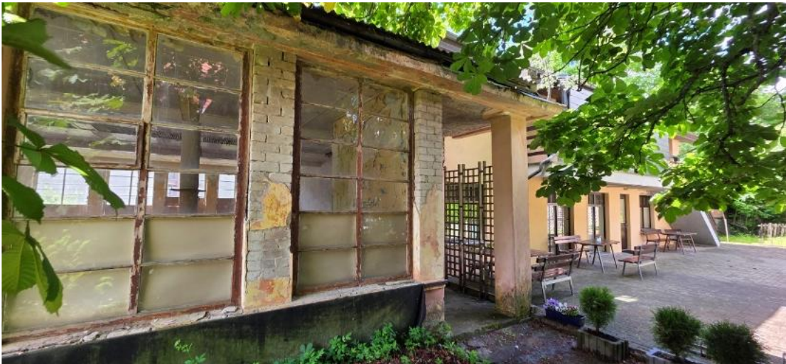
Šiaurės fasado fragmentas (pastato rytinė pusė)
