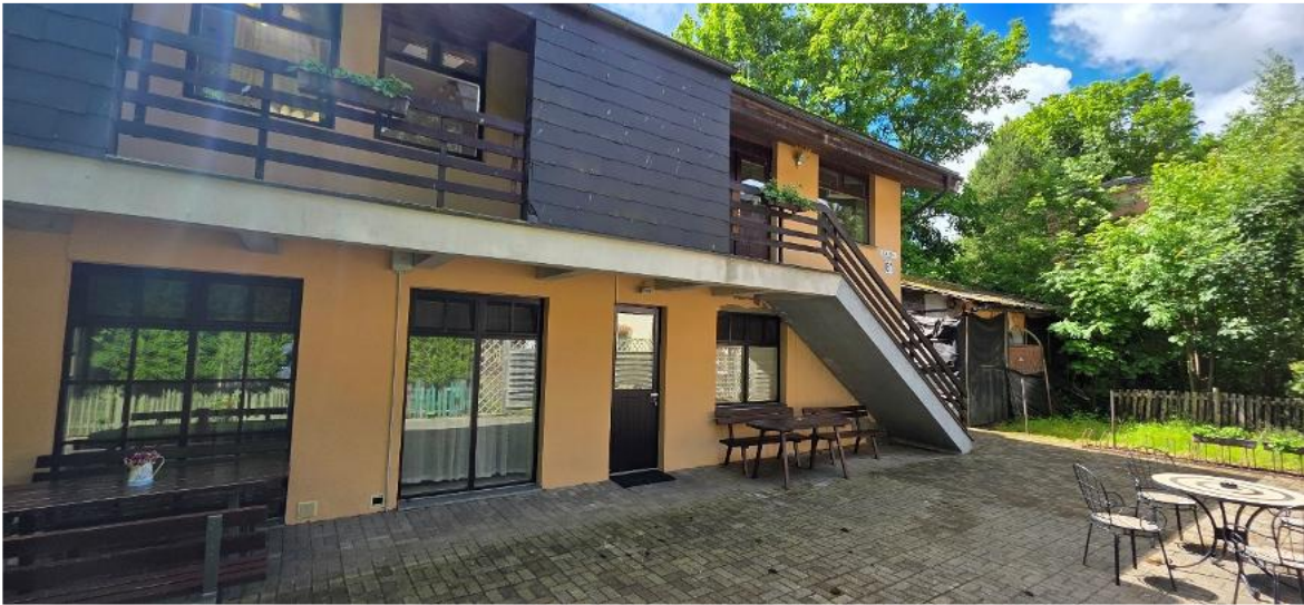
Šiaurės fasado fragmentas (pastato centrinė dalis)
