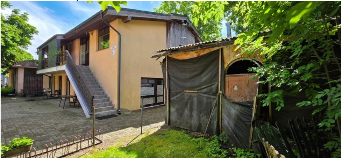
Pastato vaizdas iš ŠV pusės (pastato centrinė dalis)
