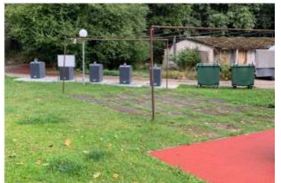
16 pav. Požemiųjų konteinerių aikštelė.
