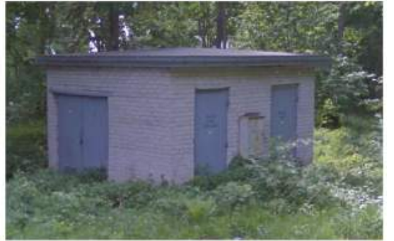
4 pav. ESO elektros transformatorinė TRN-33.
