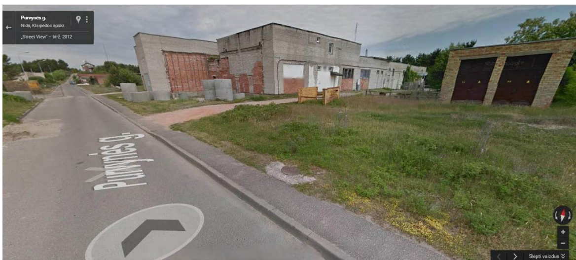
Purvynės g. 83T pastatas – transformatorinė pastotė.
