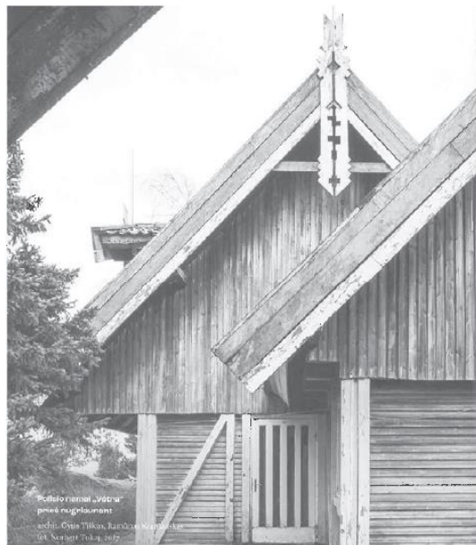
Poilsio namai „Vėtra“ prieš nugriaunant archit. G. Tiškus, R. Kraniauskas fot. N. Tukaj
