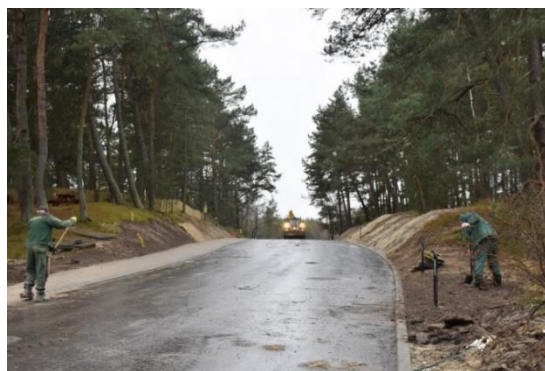
Darbai. Baigta Pervalkos gatvės rekonstrukcija.
